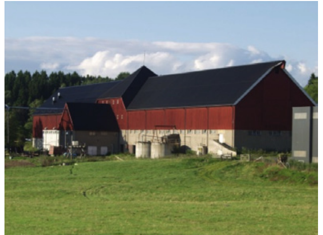
Driftsbygningen ved dagens Senter for husdyrforsk. Foto: Knut Werner Alsén.
